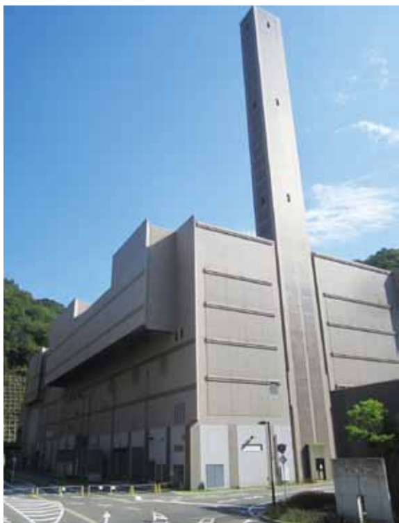
焼却灰溶融施設
