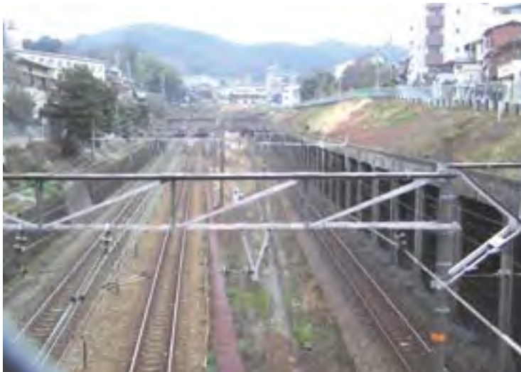
JR東大路駅の設置が期待される東海道線の新駅候補地付近
