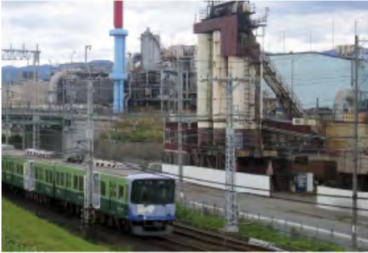
伏見・横大路地域に集中する環境関連施設の一つ「廃棄物処理工場」
