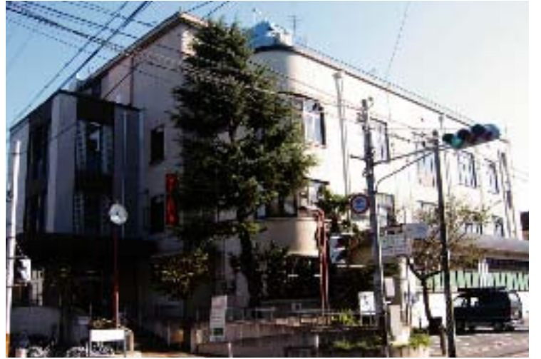
新総合庁舎完成後の跡地有効利用が望まれる現伏見区役所
