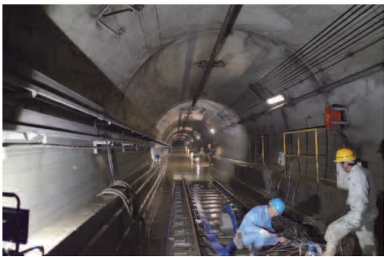
御陵駅トンネル内の冠水の状況とポンプによる排出作業
