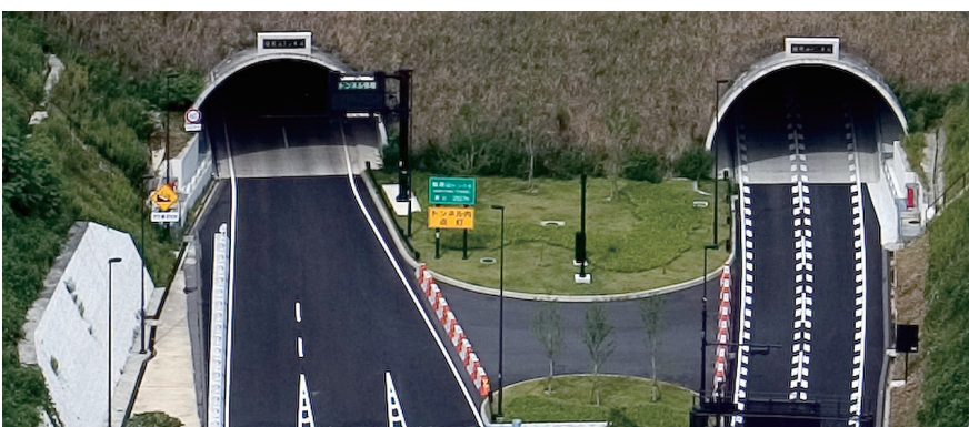
無料化される新十条通(稲荷山トンネル)
