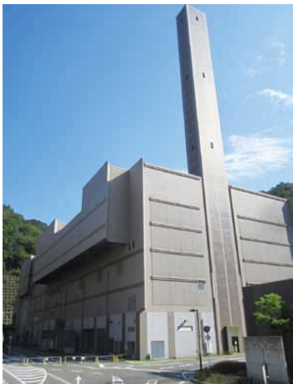
焼却灰溶融施設
