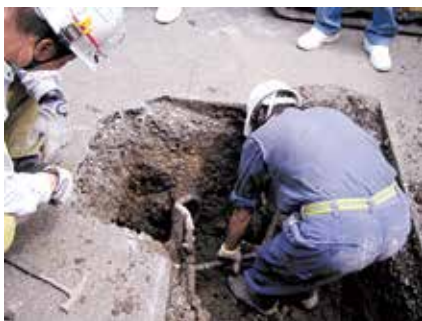
鉛製給水管の取替工事
