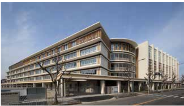
向島秀蓮小中学校（南東側外観）
