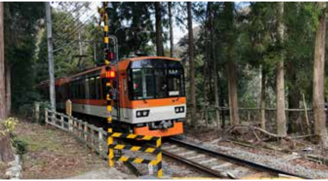
令和2年度、左京区にてインフラ施設周辺の森林整備事業を実施予定
