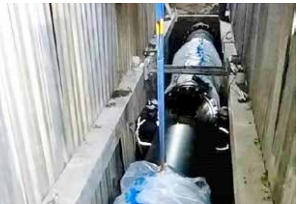
市内の水道管工事の様子
